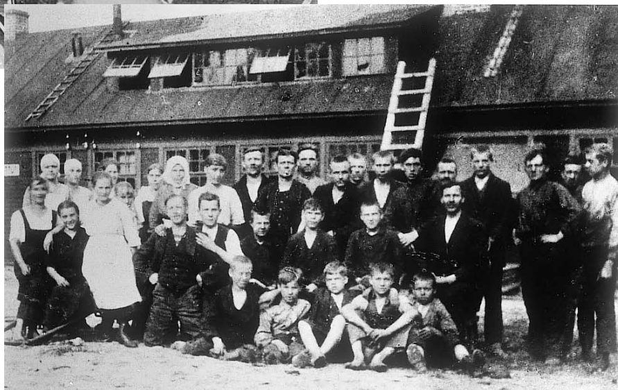
Puutyötehdas Termes ja tehtaan työntekijät v. 1924. Myöhemmin -30 luvulla rakennuksessa oli Nikulan metalliverstas. (Aulis Saviabon valokuva-arkisto)
